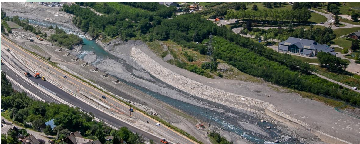
Renforcement des digues – Villargondran
