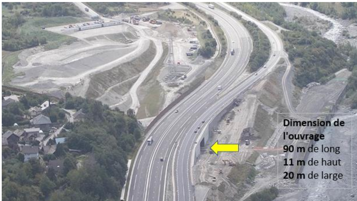
Tranchée Couverte – Saint-Julien-Montdenis
